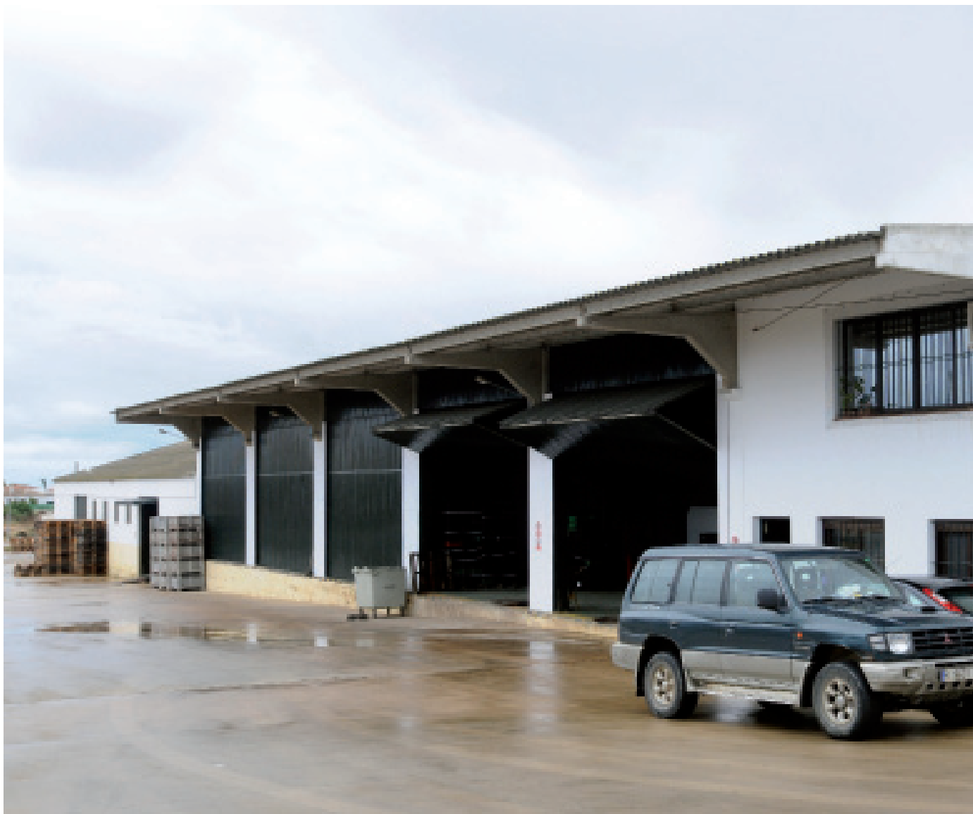
Las instalaciones de Arroyo Grande se extienden por algo más de 1.300 metros cuadrados y en la actualidad supera los 2 millones de kilos de producción fresera.
