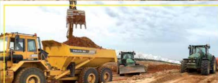
Nivelaciones y Excavaciones
