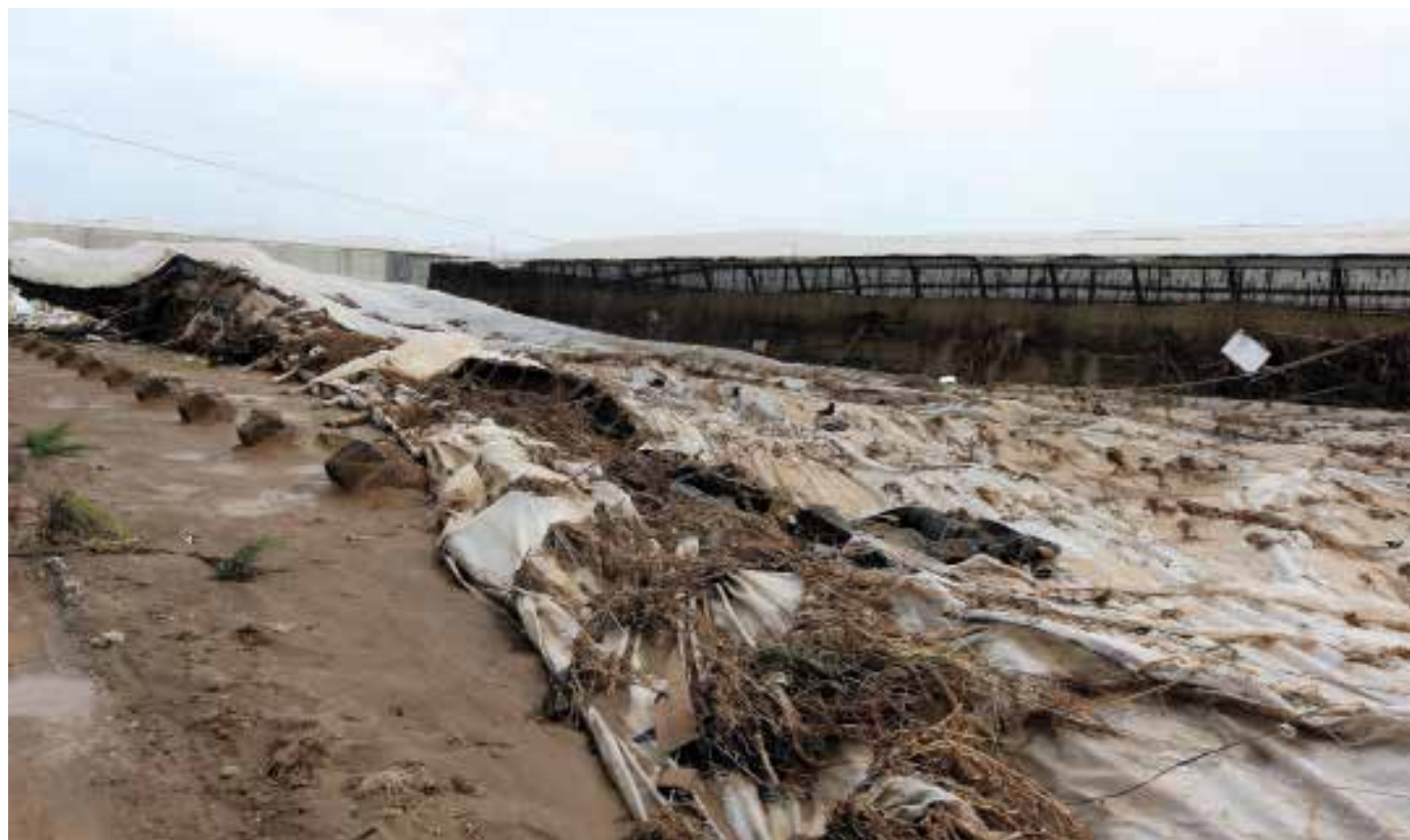
Una plantación agrícola gravemente afectada por un temporal de lluvia y viento.
