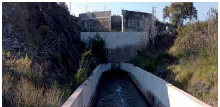
El túnel de San Silvestre es fundamental para el abastecimiento de la provincia.
