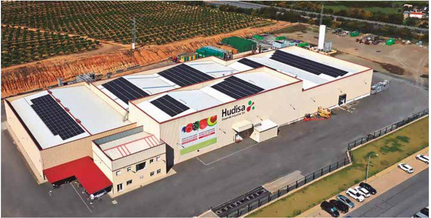
Instalaciones de Hudisa con la planta fotovoltaica en su cubierta.
