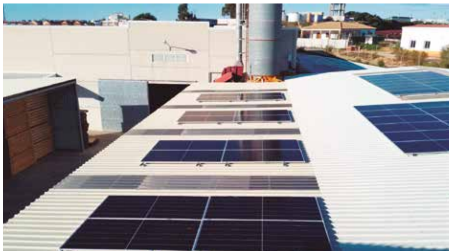
La planta tiene una capacidad de producción de más de 400.000 kWh.
