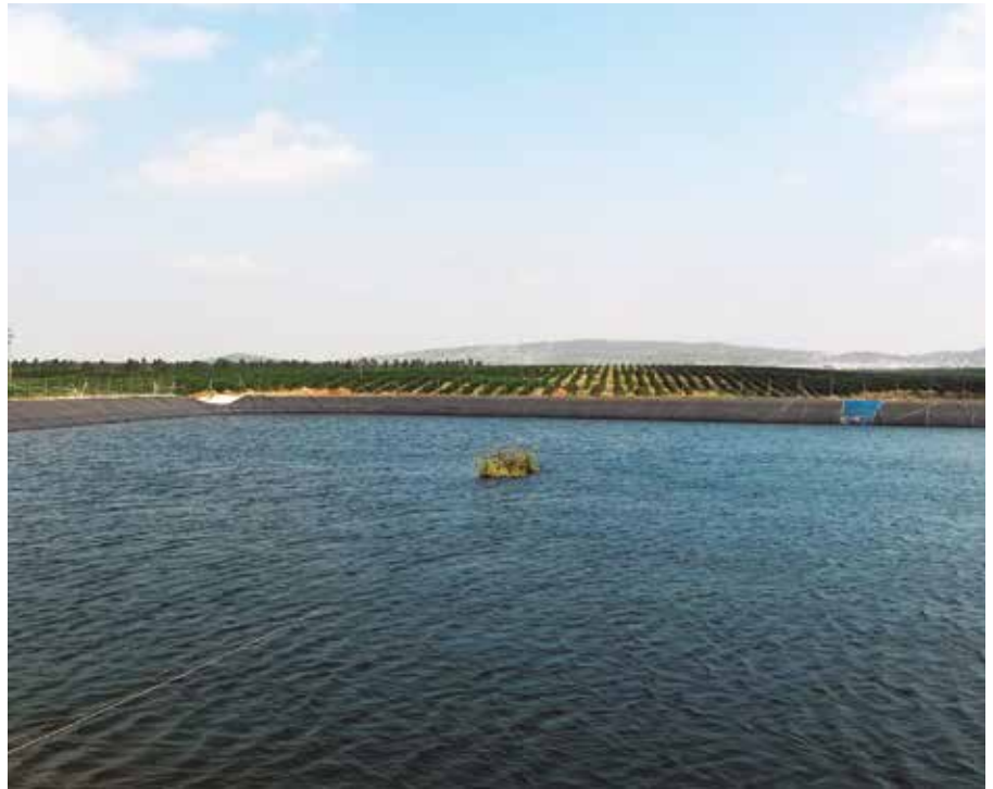
La presa del Andévalo, en la demarcación hidrográfica Tinto-Odiel-Piedras.
