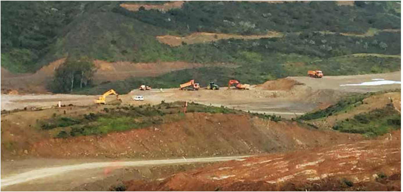
Las obras de construcción de la Presa de Alcolea fueron paralizadas.
